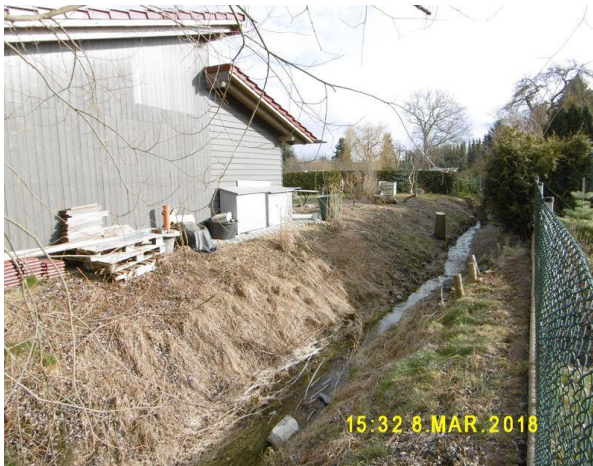
Abb. 3: Entwässerungsbereich im östlichen Bereich
